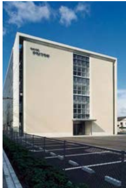
テクノプラザ外観
